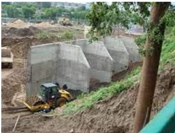
Рис. 3.47. Приклад підпірної стінки [35]
