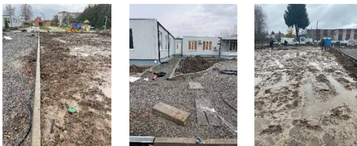
Рис. 4.4. Проведення монтажних робіт на території дитячого дошкільного закладу (фото автора)
