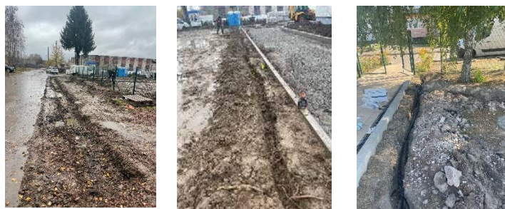
Рис. 4.3. Викопування траншеї для прокладання автоматичної системи поливу (фото автора)
