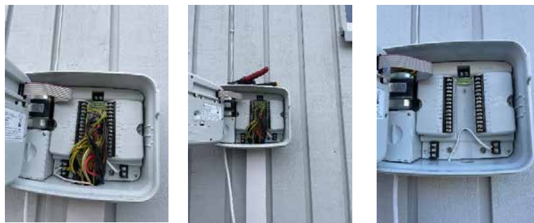
Рис. 4.5. Монтаж контролера (фото автора)
