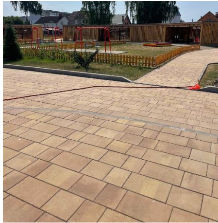
Рис. 3.2. ФЕМ-ове покриття на доріжках дитячого дошкільного закладу (фото автора)
