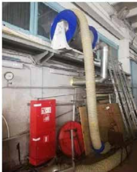
Рисунок 3.15 – Витяжний пристрій для відведення відпрацьованих газів
