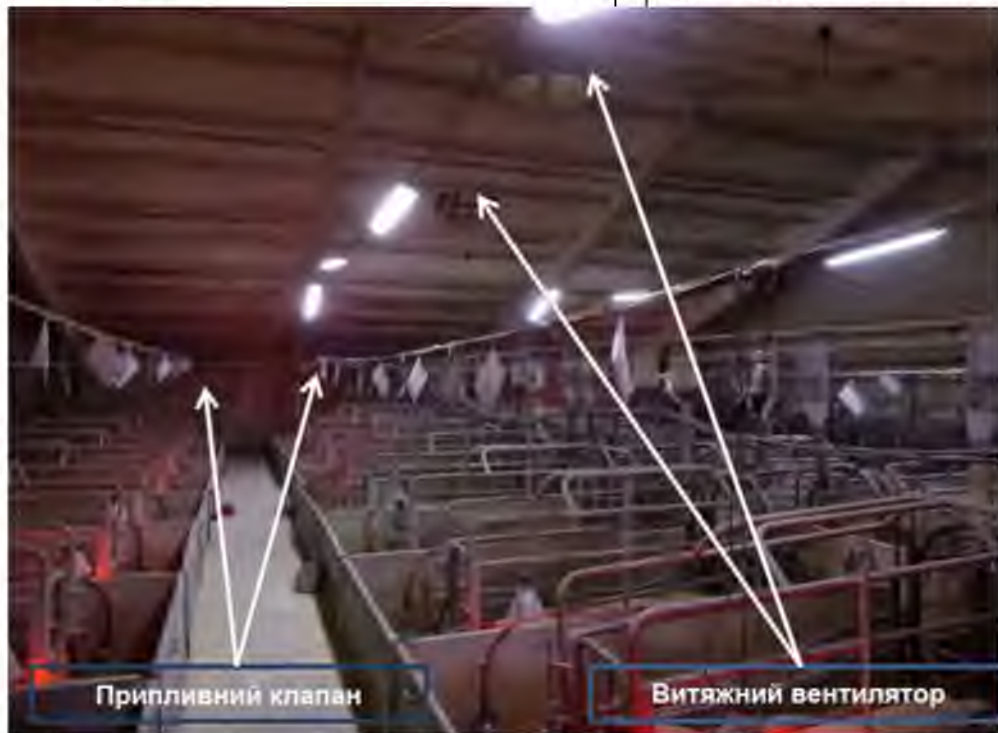
Рис. 1.4. Забезпечення вентиляції в цеху опоросу (піденні свиньмати та поросята-снеунн). [30]
