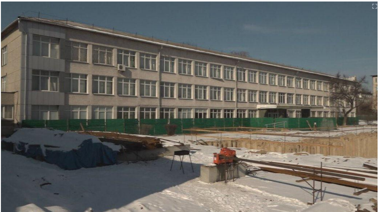
Рисунок 10 - Розташування будівлі ліцею відносно котловану
