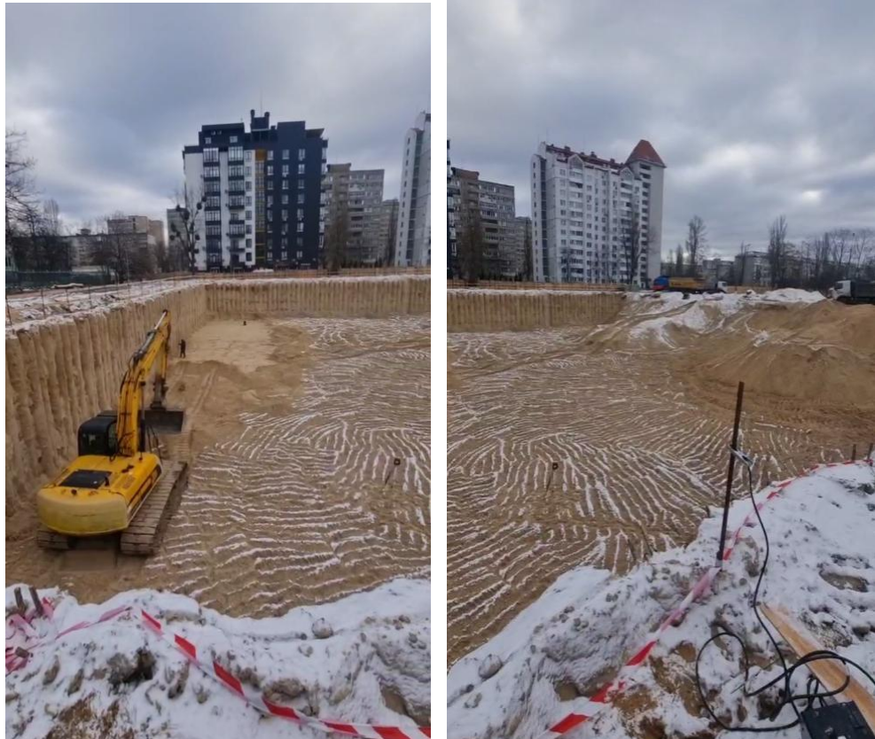
Рисунок 2.6 - Процес розробки котловану
