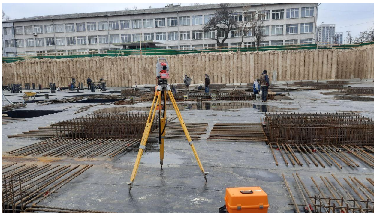
Рисунок 2.9 - Процес супроводу улаштування арматури (армокаркасів) на Пфм-1 тахеометром Alpha-GEO X
