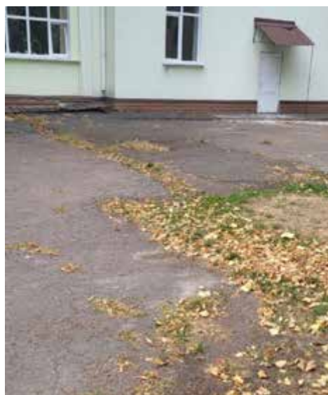
Рис. 2.16. Дорожнє асфальтоване покриття (фото автора)
