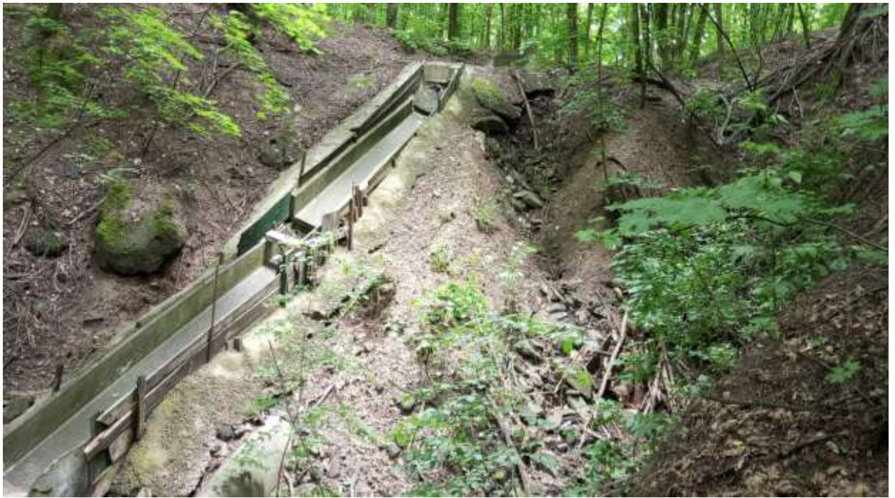
Рис. 3.8. Загальний вигляд стану протиерозійних споруд (лотків-швидкотоків)
