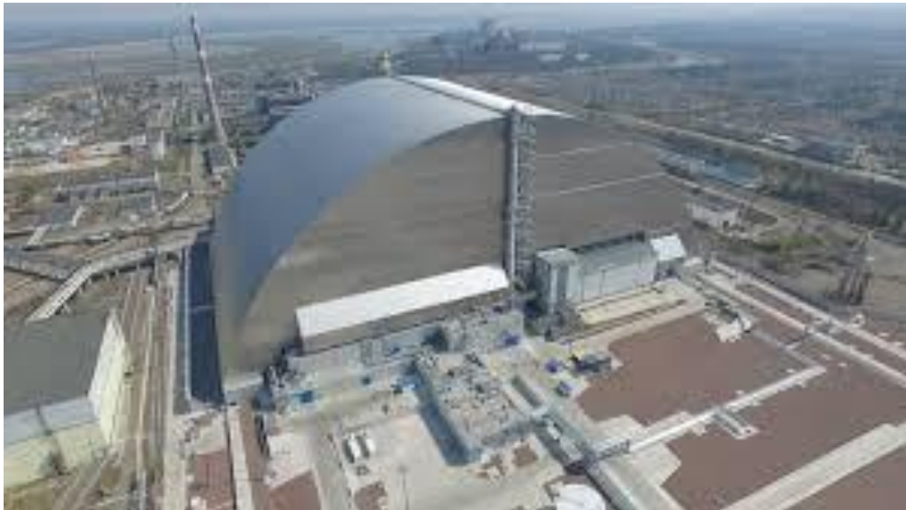
Рисунок 4.1 – Будівництво нового саркофагу у формі арки [24]
