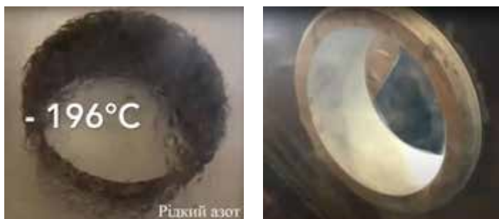
Рис. 1. Встановлення сталеві втулки в корпус із застосуванням глибокого холоду (кріогенний метод)
