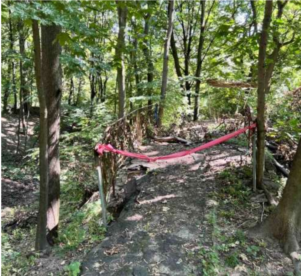
Рис. 2.10. Аварійний стан містків на території парку (фото автора, 2023 р.)
