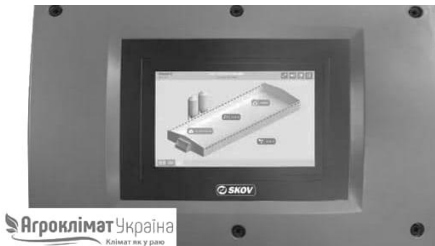
Рисунок 2.2 Вигляд комп'ютера автоматичної системи контролю мікроклімату в корівнику.
