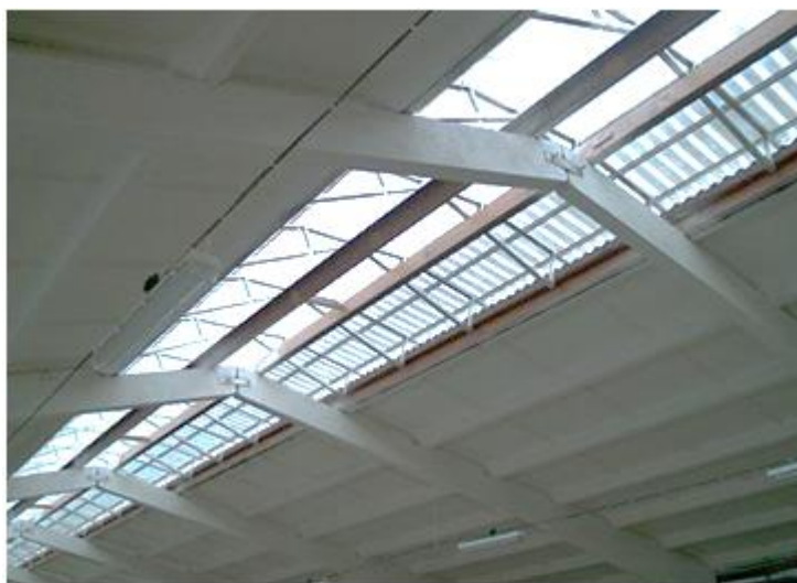
Рисунок 1.2 Люк у даху для освітлення та вентилявання корівника
