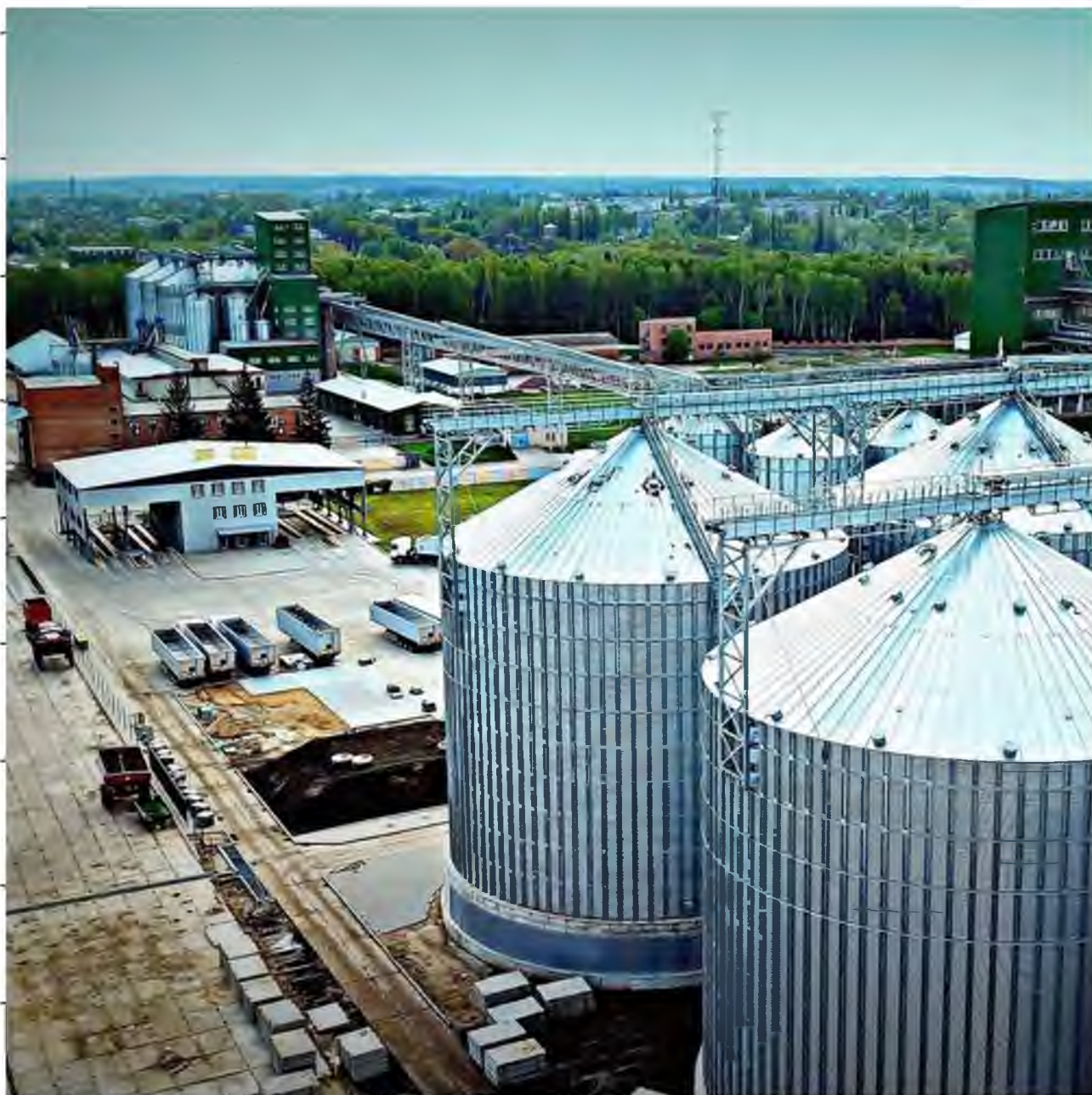
Рис. 1.1 – Будівлі на території Кролевецького комбікормового заводу
