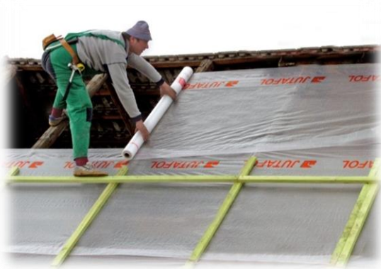
Рис.4.1.3. Пристрій гідроізоляції
