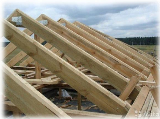
Рис.4.1.2. Влаштування кроквяної системи
