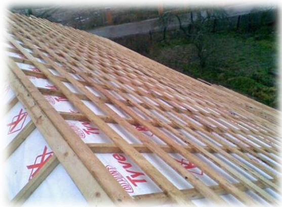
Рис.4.1.4. Влаштування обрешітки
