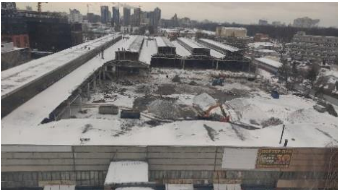
Рисунок 1 – Загальний вигляд конструкцій промислового корпусу, що підлягають демонтажу (вид з 10-го поверху офісної будівлі, що обстежується)
