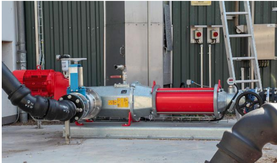
Рис. 1.7. Ексцентрично-шнековий насос Vogelsang CC-серії на біогазовому виробництві
