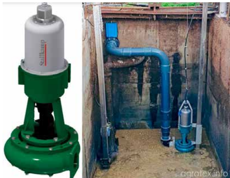
Рис. 1.6. Відцентровий насос високого тиску ТМНР (Vogelsang) для перекачки гною
