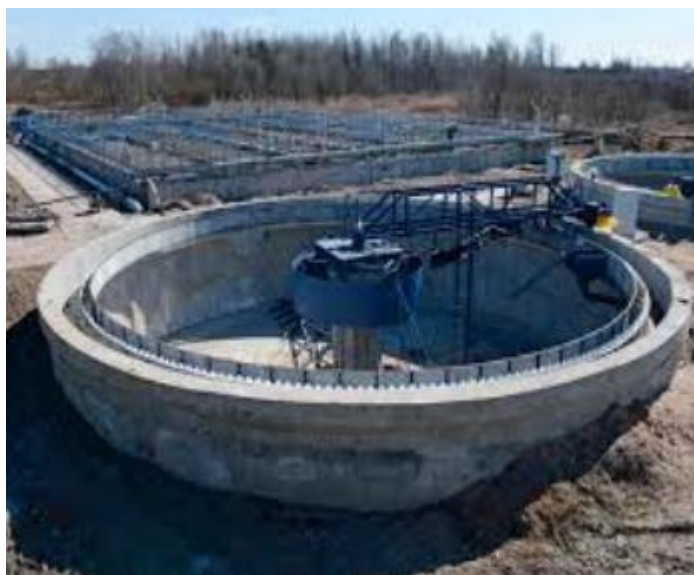
Рис. 1.4. Корпус метантенка на стадії будівництва із наливного бетону
