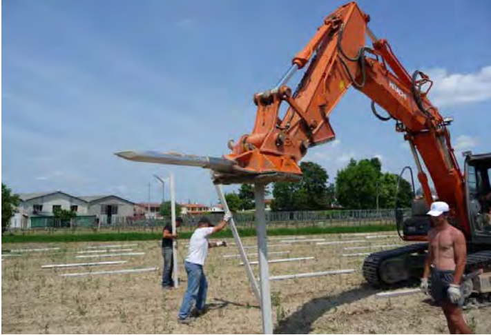
Рис.62. Гідравлічний стовп остав у роботі.
