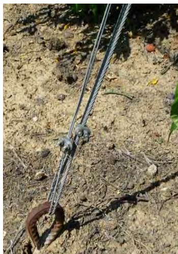
Рис. 37/1. Якір для закріплення та фіксації кінцевих бетонних стовпів: ліворуч – в упаковці, праворуч - у ґрунті.
