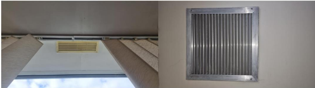
Облаштування вентиляційних отворів системи припливно-витяжної вентиляції приміщень
