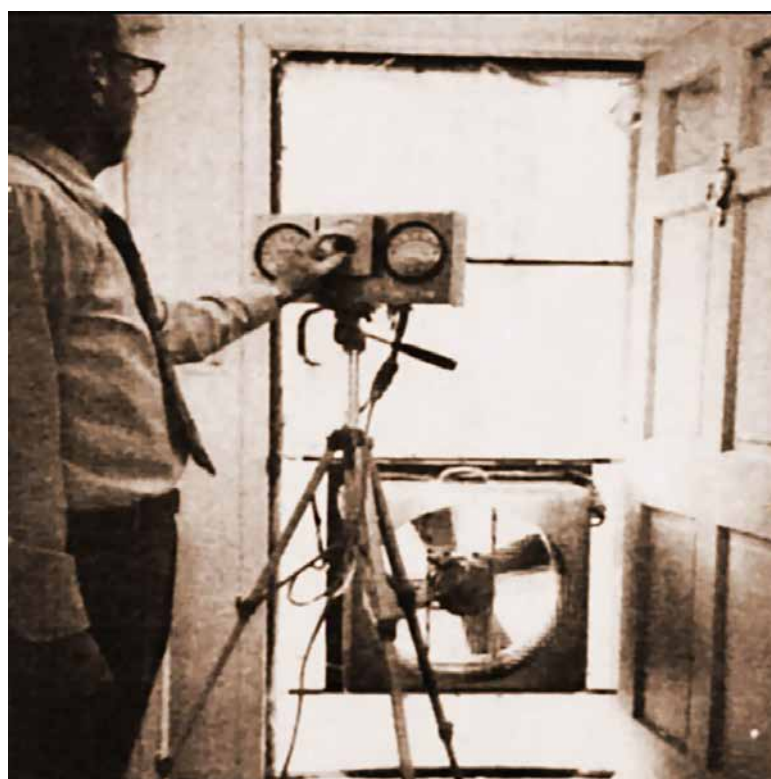
Рис. 1.1. Приклад використання обладнання Blower Door (Аеродвері): а – Retrotec; б - Energy Conservatory
