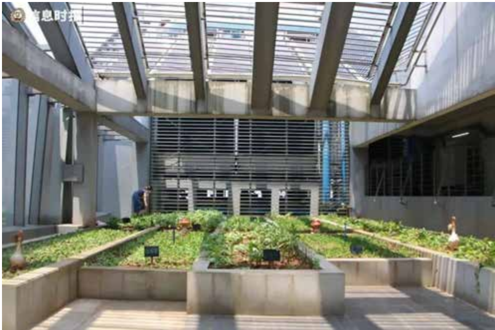
Рис. 2.4. Ферма Тяньцзі в Yuexiu Financial Building розташована на 70 поверсі будівлі і займає площу близько 250 квадратних метрів
