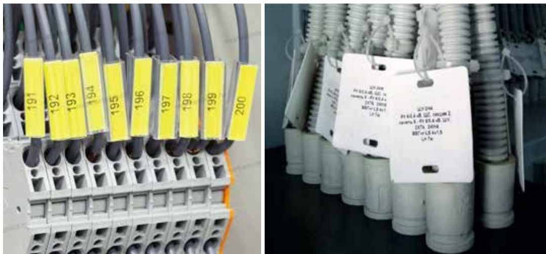
Рис.5.1. Фото маркувань кабельних ліній
