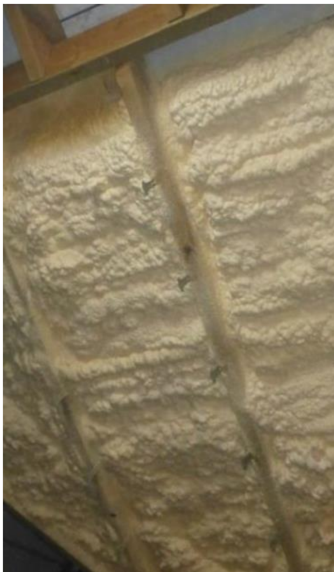
Рис. 1.8. Метод наплення з використанням ППУ [3]
