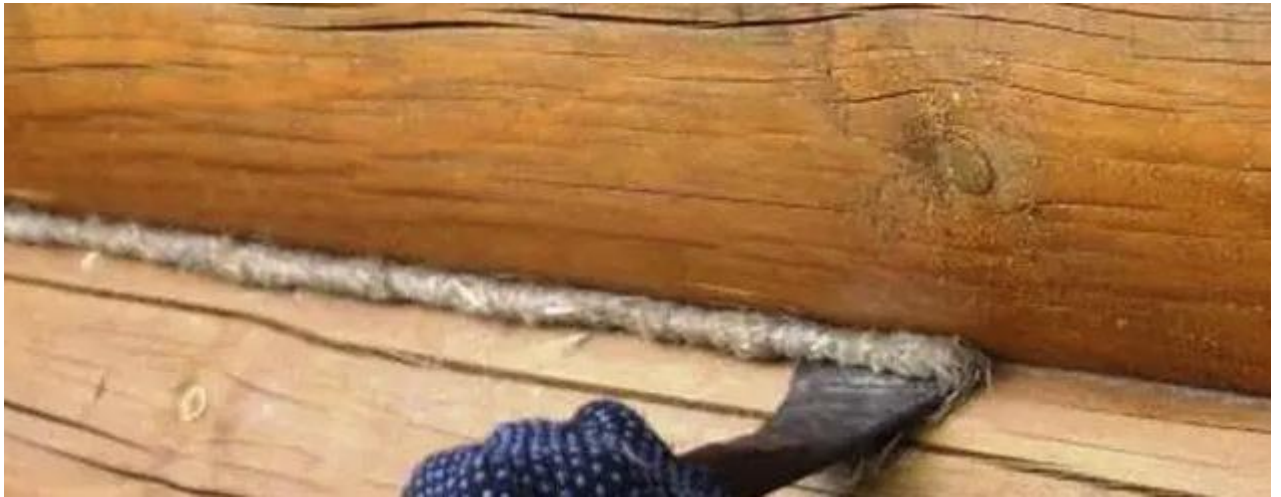
Рис. 1.11. Конопачення швів зрубу [11]
