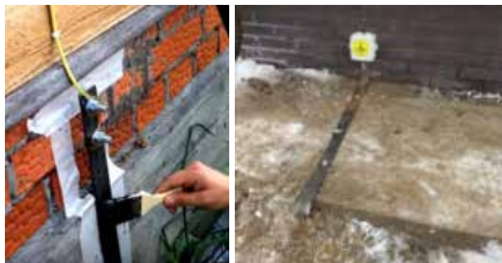
Рис. 2.11. Елементи заземлювального пристрою, що не допускають (а) і потребують (б) захисного фарбування
