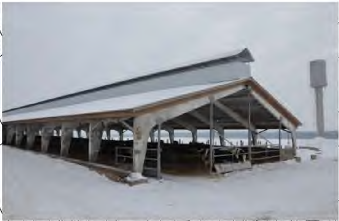
Рис. 2.2.5. Фрагмент використання напіврамних конструкцій при реконструкції ферми ТОВ «СК Восток» для утримання на накопичувальній підстилці.
