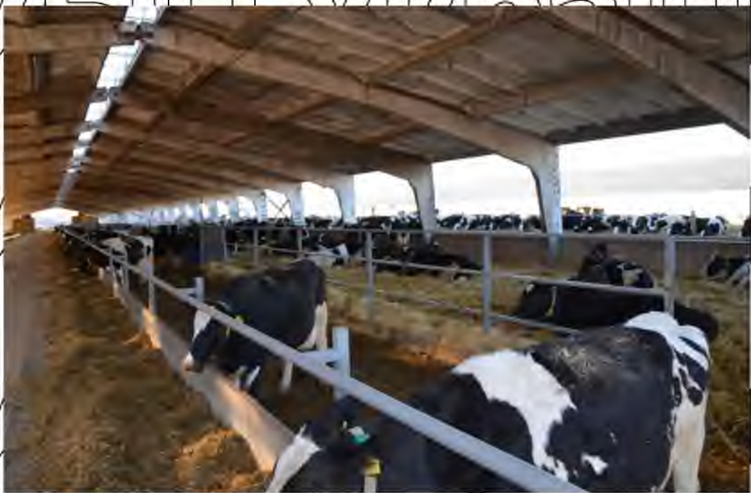
Рис. 2.2.4. Фрагмент використання напіврамних конструкцій при реконструкції ферми ТОВ «СК Восток» для утримання корів на накопичувальній підстилці.
