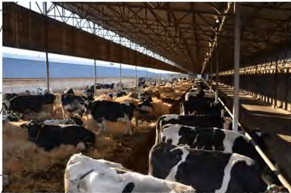
Рис. 2.2.7. Фрагмент використання опірних конструкцій при будівництві ферми ТОВ «СК Восток» для утримання на накопичувальній підстилці (орієнтація зони відпочинку корів -на південь).
