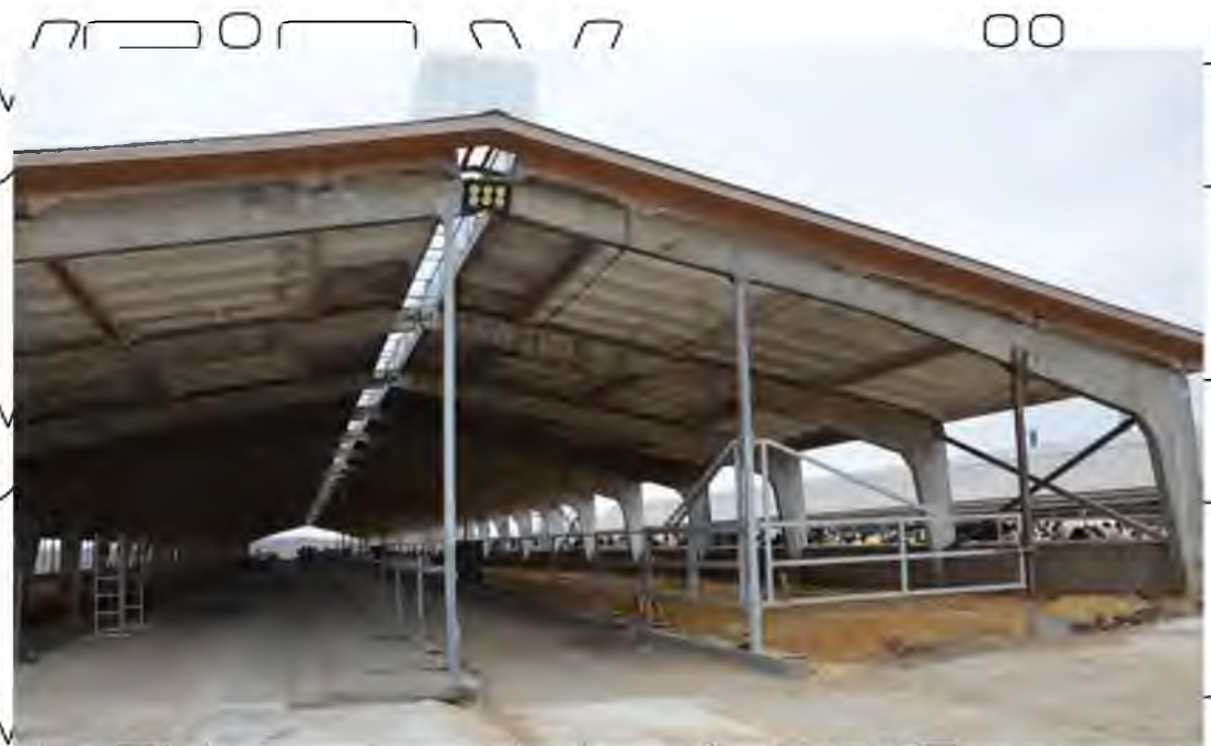
Рис. 2.2.6. Фрагмент використання напіврамних конструкцій при реконструкції ферми ТОВ «СК Восток» для утримання корів на накопичувальній підстилці.
