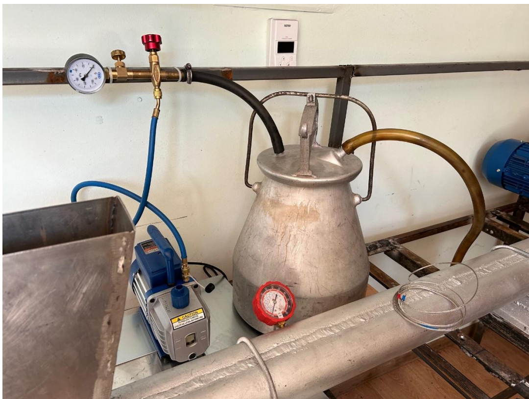
Рис.4.13. Встановлення манометру REFCO BM2-6
