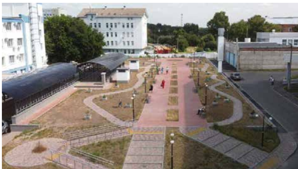
Рис. 1.7. Газон на даху підземного паркінгу для карет швидкої допомоги Комунального підприємства Полтавського обласного центру екстреної медичної допомоги та медицини катастроф [26]
