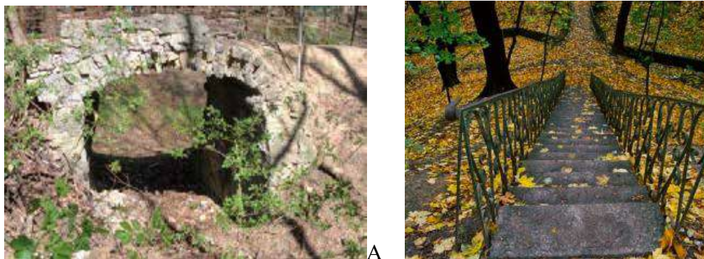
Рис. 2.4. Арковий місток над яровою боковою западиною (А); бетонні сходи (Б) (фото автора, 2023 р.)
