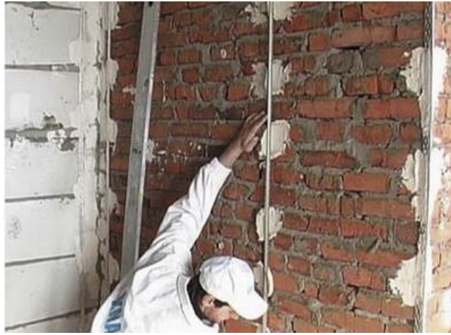
Рис. 3 - Установка маяків на ляпки.
