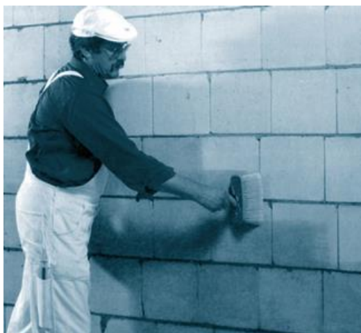
Рис. 1 - Нанесення ґрунтовки на поверхню.
