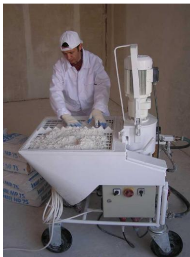
Рис. 4 - Приготування суміші.
