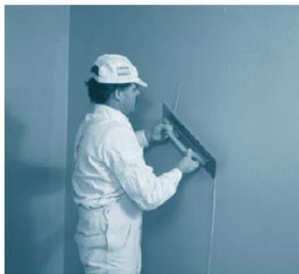
Рис. 7 - Загладження поверхні металевою терткою.
