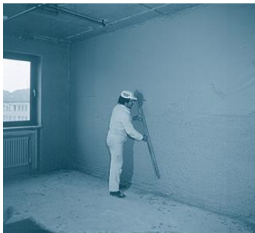
Рис. 6 - Вирівнювання нанесеної розчинної суміші правилом.
