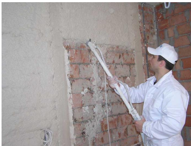
Рис. 5 - Нанесення та вирівнювання розчинної суміші.
