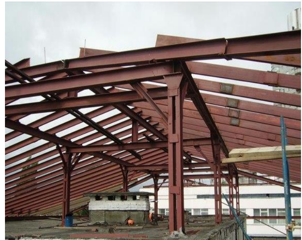
Рис. 2.12. Приклади центрально-стиснутих колон на планках [2]:
