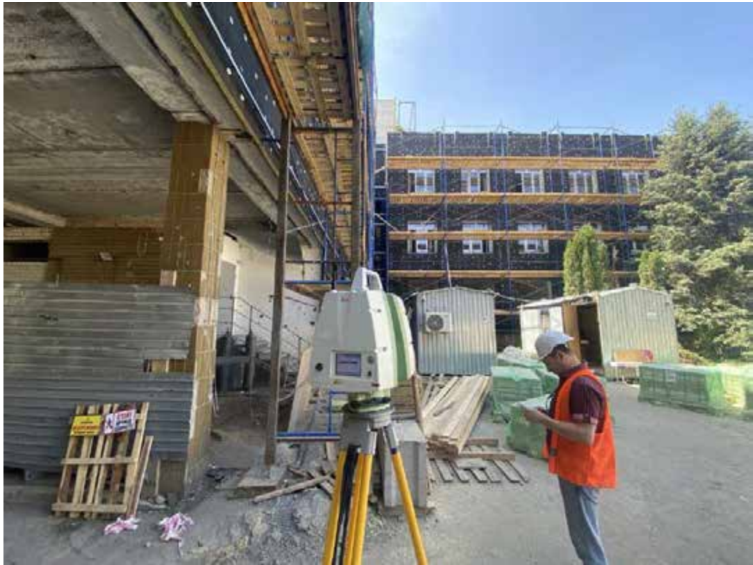
Рис. 1.7 Сканування зруйнованого об'єкту для його відновлення.
