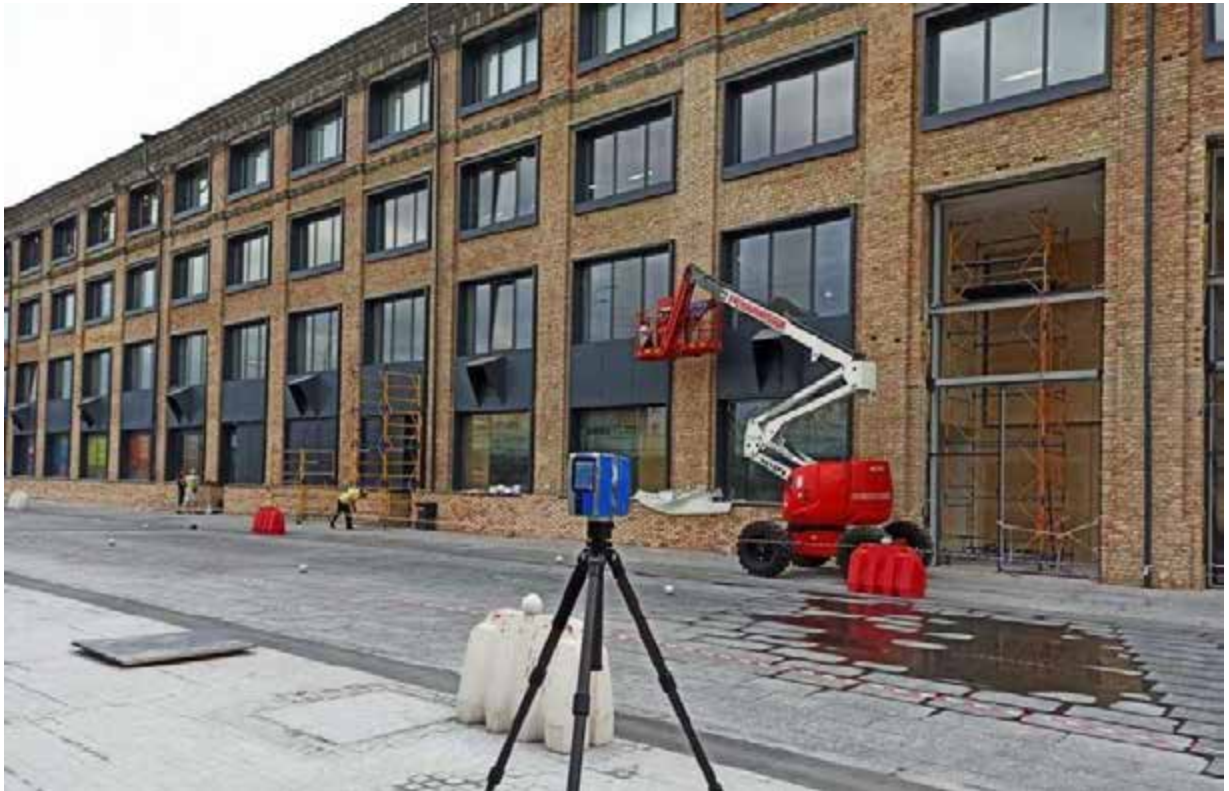
Рис. 1.5 Використання наземного лазерного сканера на будівництві.
