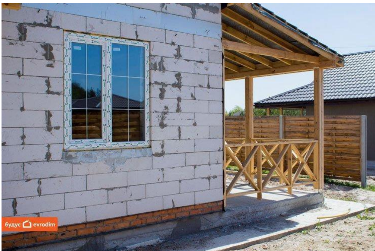
Рис.1.7 будинок з газоблоку
