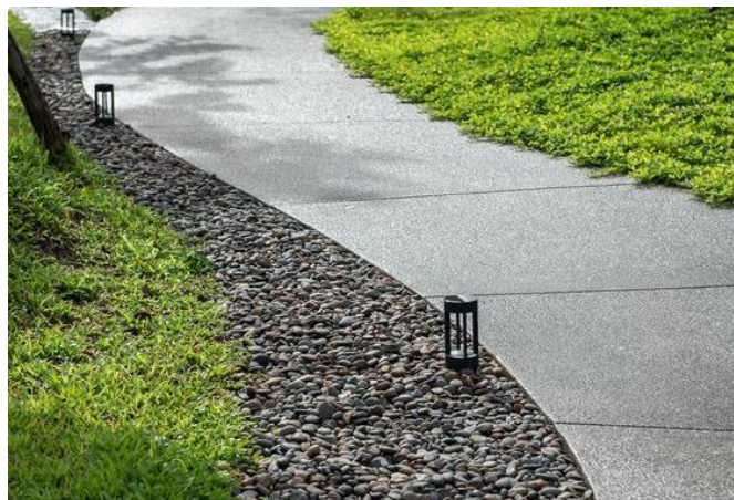
Рис. 4.2. Приклад монолітно бетонного покриття [33]
