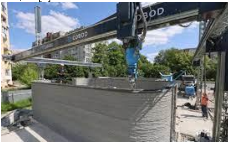
Рис. 3. 3D-принтер на будівництві
