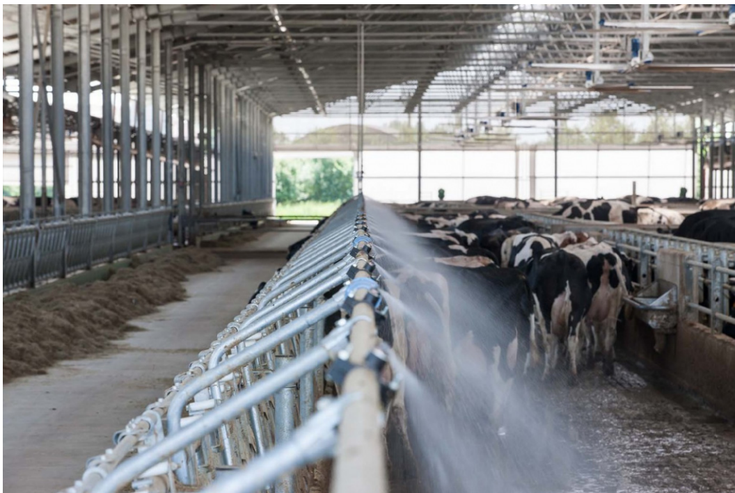
Рис. 1.55. Застосування системи зволоження повітря для підвищення охолоджувальної здатності [81]
