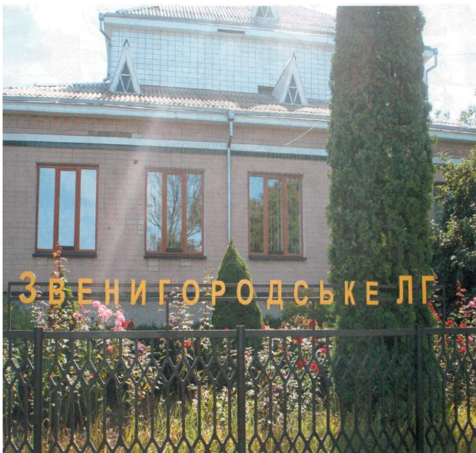
Рис. 3.1. Адміністративна будівля Звенигородського надлісництва
