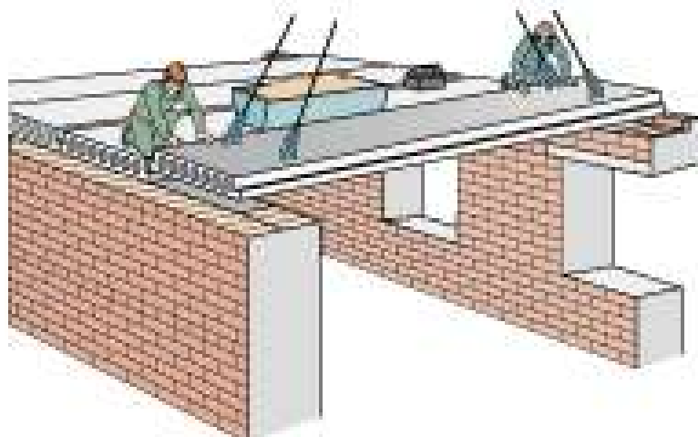
Рис. 3.3 – Монтаж плит перекриття
