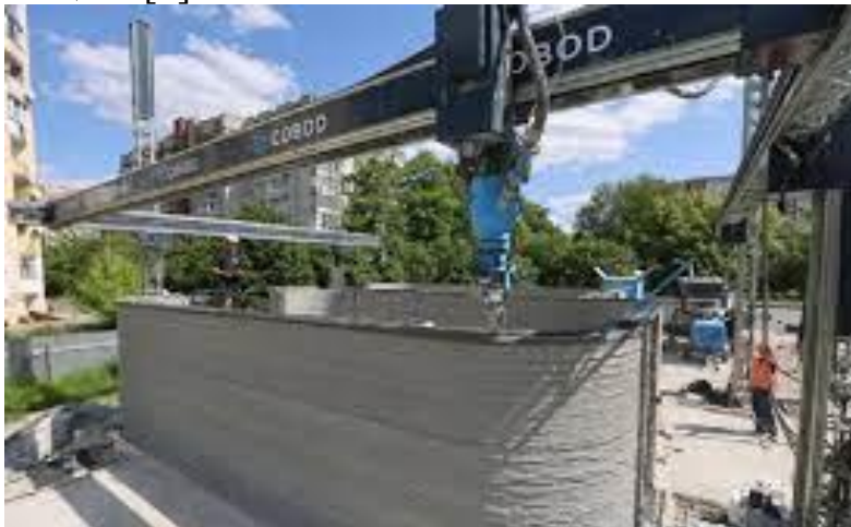
Рис. 3. 3D-принтер на будівництві
