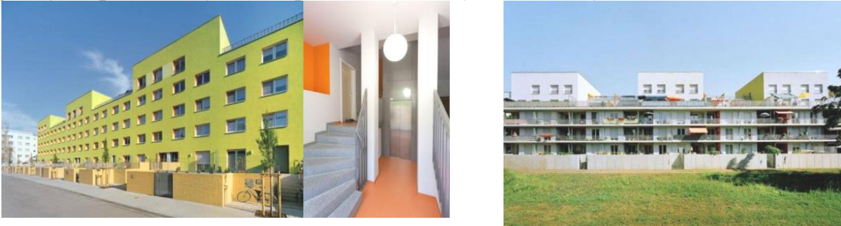
Рис.1. Житлова будівля 2012р. Житлова площа: 7,3 тис.
