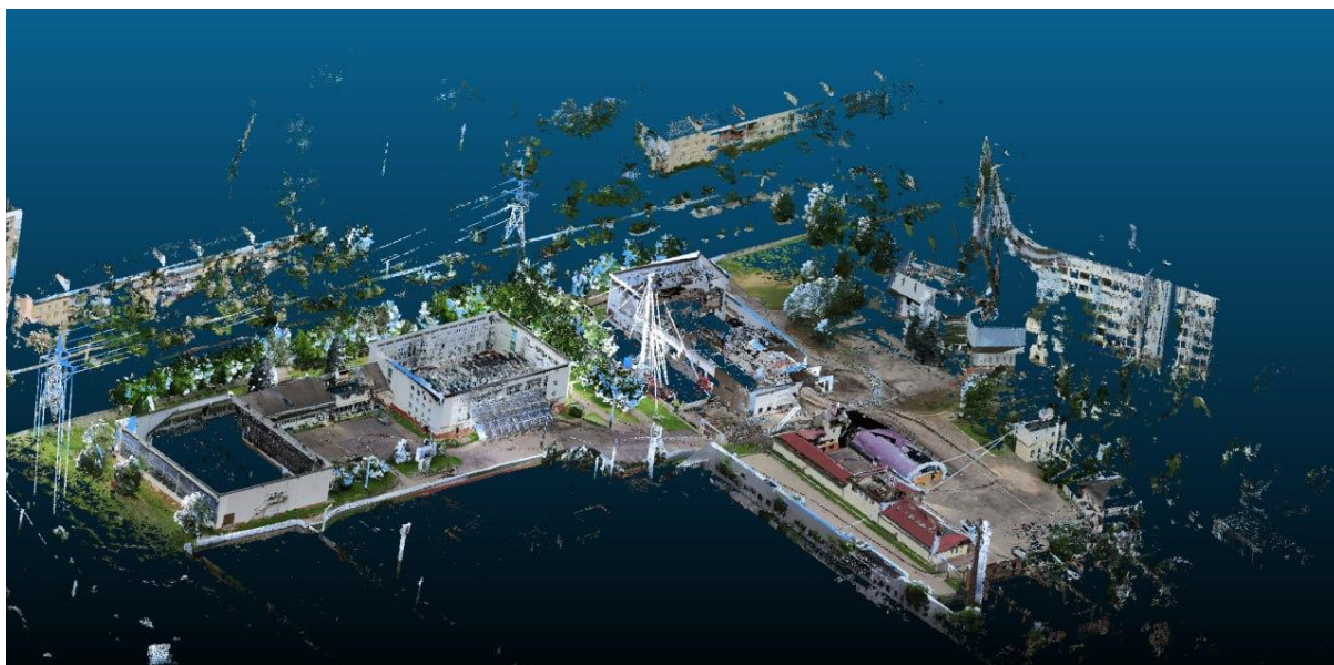
Рис. 2 Кольоризована хмара точок пошкоджених будівель ІФНТУНГ
