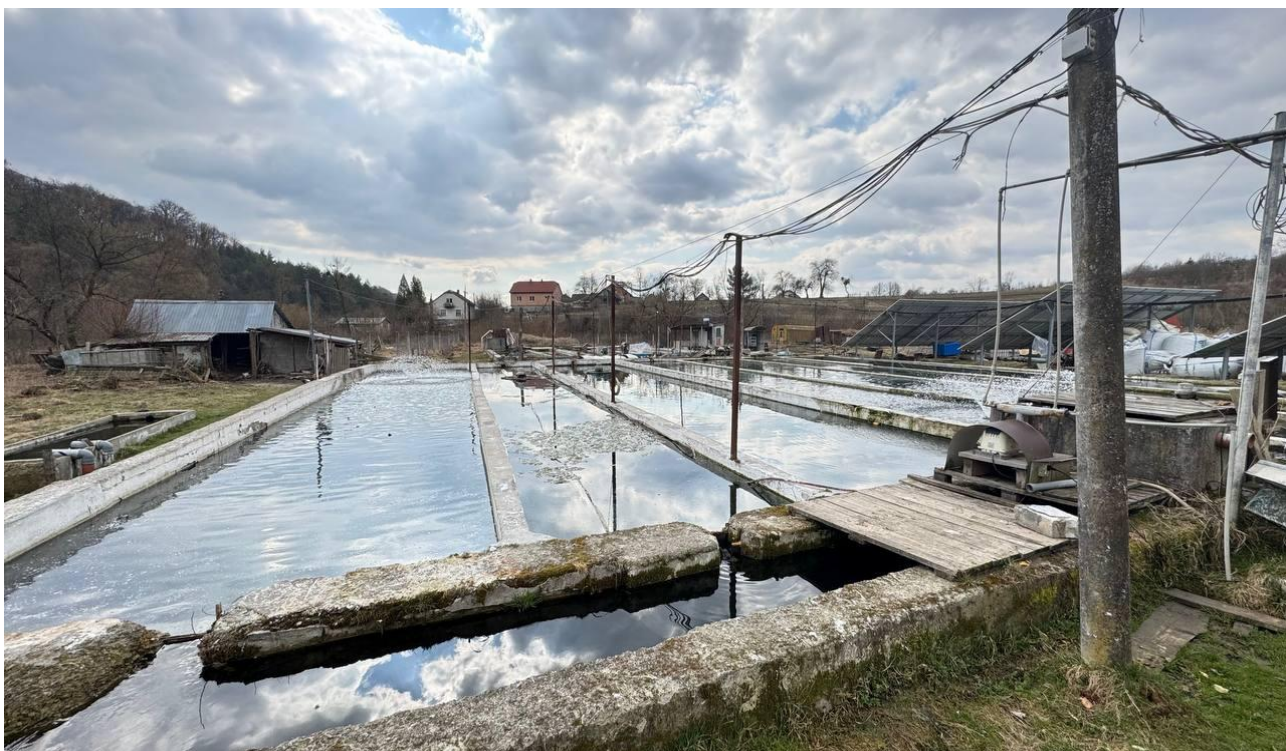
Рис. 3.4.2. Залізобетонні басейни для підрощення форелі
