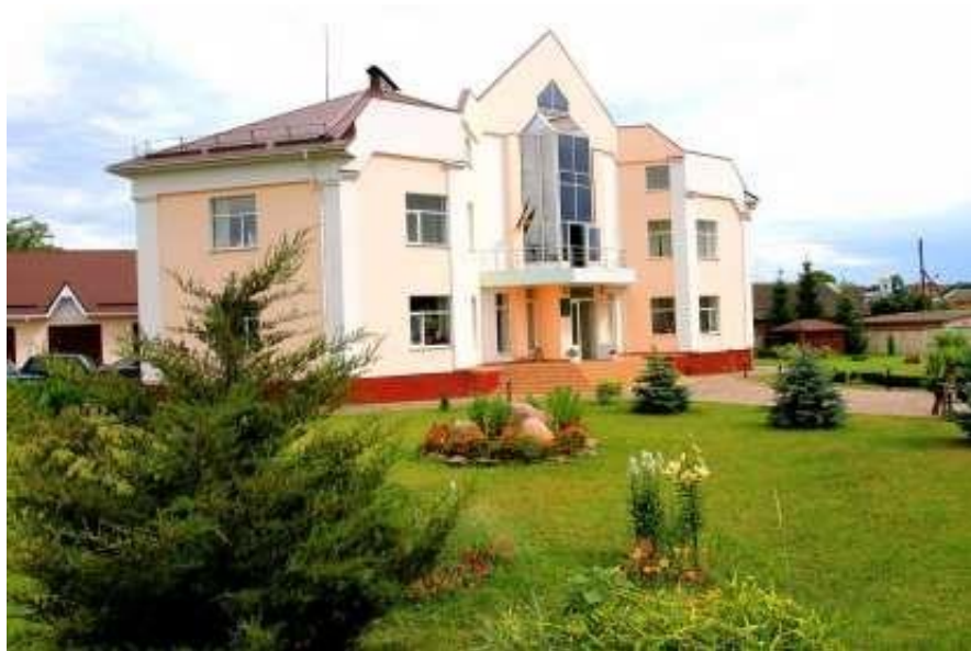
Рис. 3.1. Адміністративна будівля філії «Ніжинське лісове господарство»
