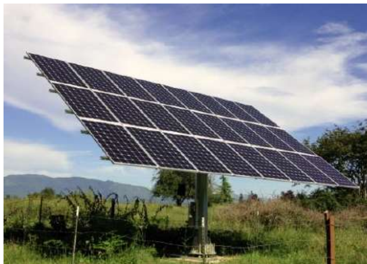
Рис. 1.5. Двохосьовий трекер із віссю обертання на несучому стовпі
