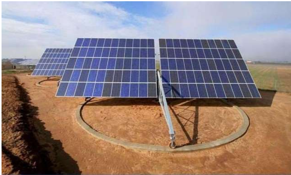
Рис. 1.6. Двохосьовий сонячний трекер із опорною площиною
