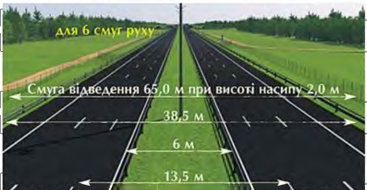
Рис. 3.2 - Дорожнє полотно нової Київської обхідної дороги
