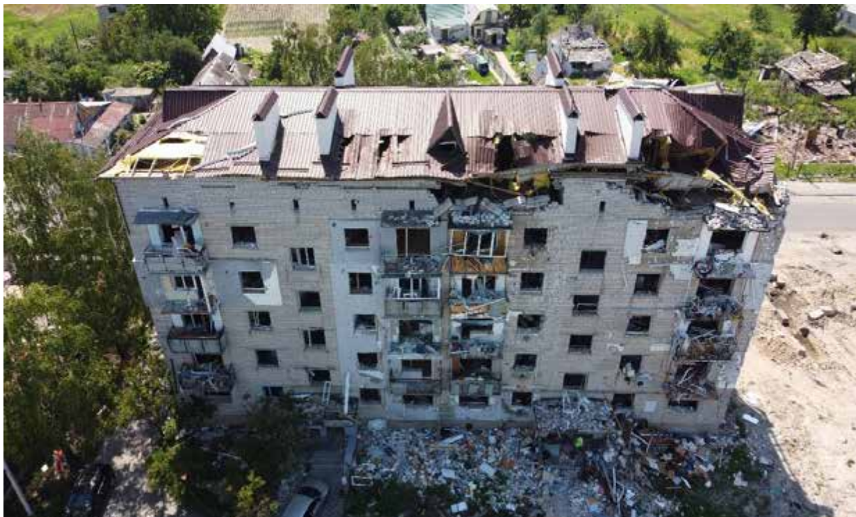
Рисунок 1 – Приклад руйнування будинку по вул. Центральна, 324, смт. Бородянка
