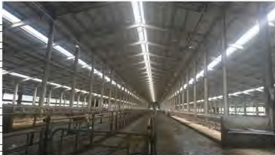
Рис. 2.1. – Приміщення для утримання корів
