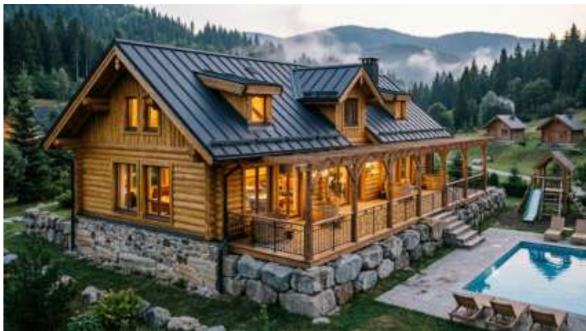
Рис. 3.2. Приклад оформлення сервісної будівлі бази-відпочинку «Карпатський хутір»
