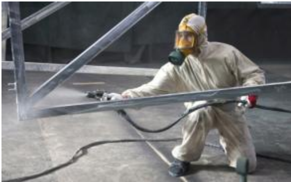
Рис. 1. Нанесення лакофарбового покриття
