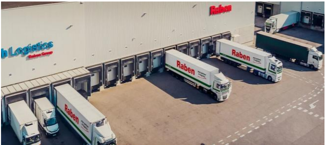
Рис. 3.2. Приклад торцевої схеми розстановки автомобілів
