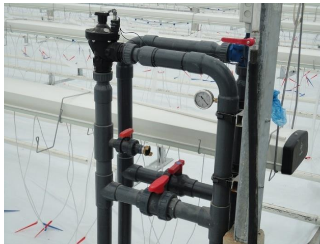
Рис. 1.12. Моторизовані крани для точної дотації крапельного поливу
