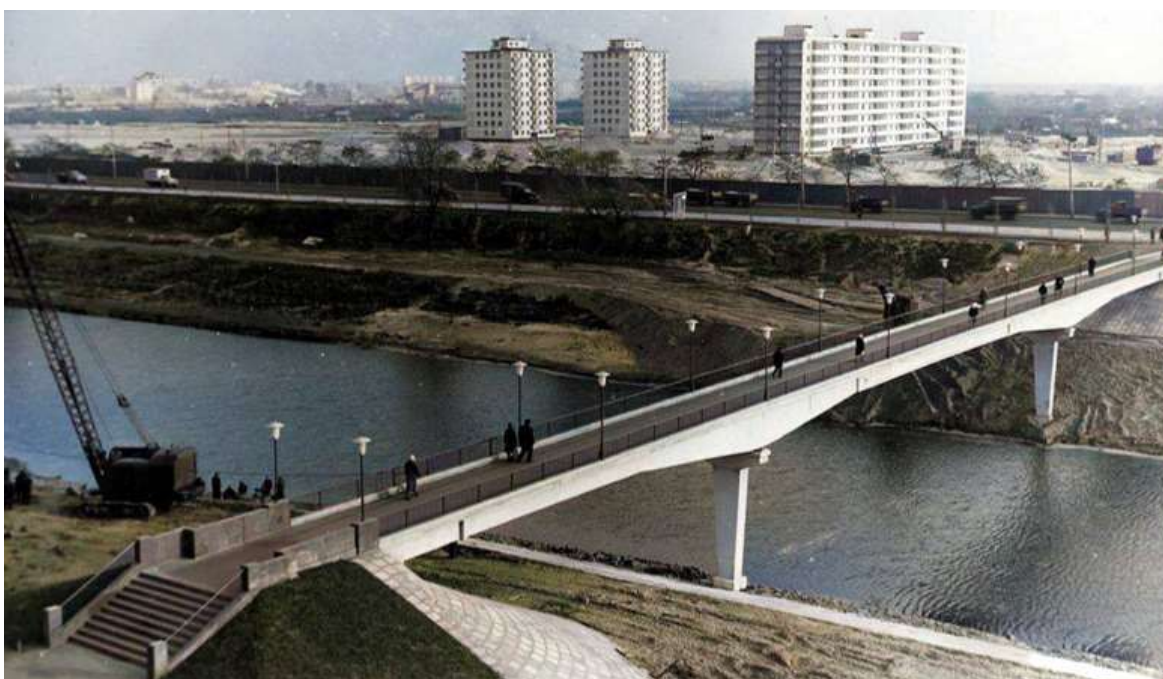
Рис. 2.1 Фото Русанівського пішохідного мосту №1 в 60-х роках ХХ ст.
