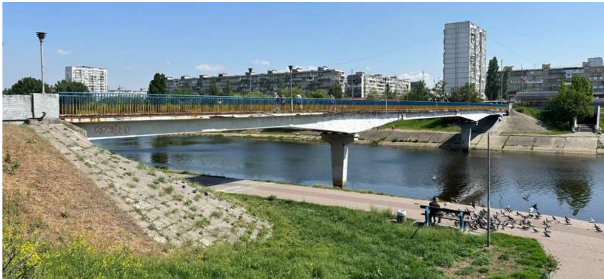
Рис. 2.2 Фото Русанівського пішохідного мосту №1 теперішнього часу.
