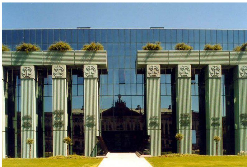
Рис. 3.3. Будівля Вищого Суду у Варшаві, 1996-2000, проєкт: Марек Будзинський, Збігнєв Бадовський, фот. Марек Будзинський [16]
