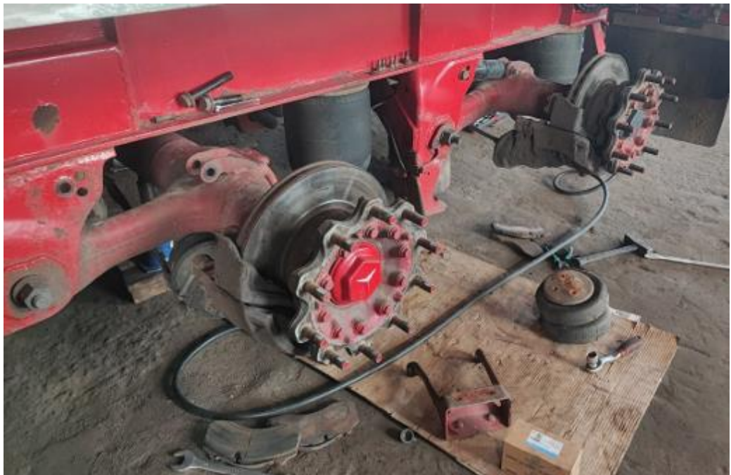
Рис. 1.6. Технічне обслуговування гальмівної системи напівпричепа
