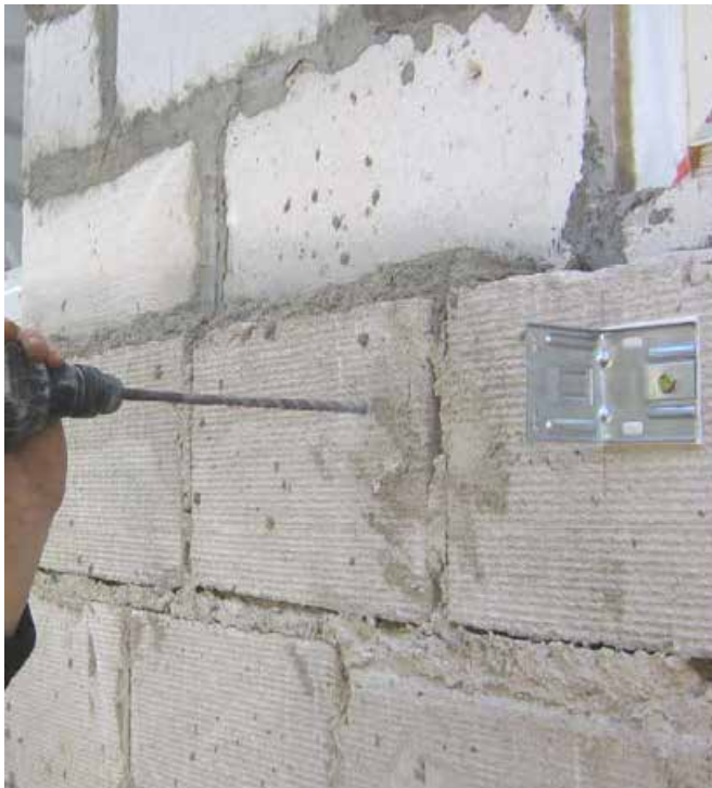
Рис. 3.2. Свердління стіни
