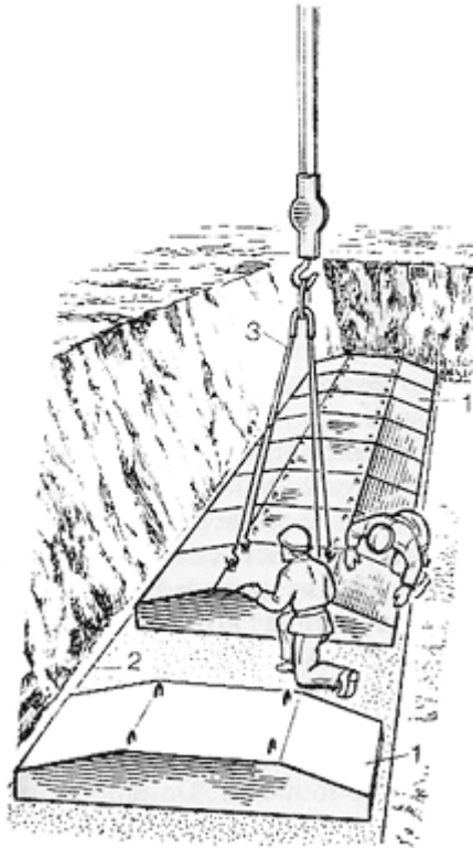
Рис 3.1. Монтаж фундаментних подушок
