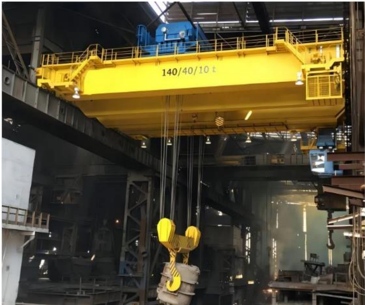
Рис. 1.8. Мостовий ливарний кран
